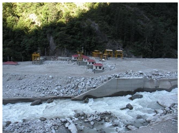
Vishnuprayag Barrage Site
